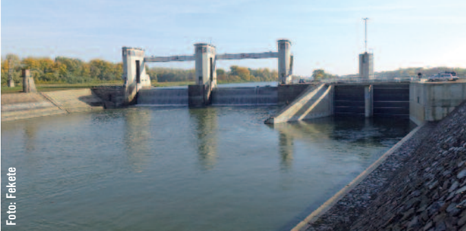
Der Békésszentandrás-Staudamm wurde zwischen 1936 und 1942 gebaut. Er dient der Bewässerung, der Schiffbarkeit und dem Hochwasserschutz.
